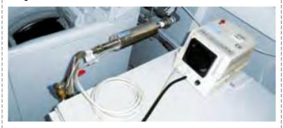
Abbiamo provato l'efficacia di Acquasonic, un sistema che applica un campo elettromagnetico alla tubatura dell'acqua per prevenire il calcare "alla fonte" attraverso un meccanismo fisico di trasformazione del carbonato di calcio in cristalli di aragonite, anziché di calcite. Si tratta di un apparecchio che viene montato sul tubo d'ingresso dell'acqua e collegato alla rete elettrica. Ottimo l'effetto protettivo anticalcare sulla serpentina, ma pessimo quello sulla biancheria, che rimane rigida.
